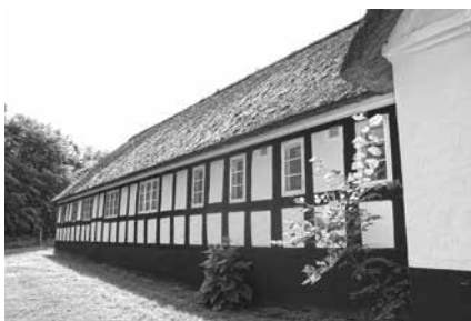
Nordvæggen af den gamle bindingsværksbygning 2014.
